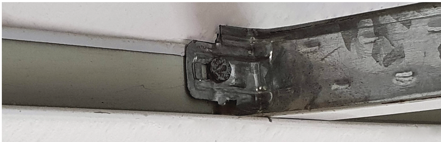
Perfil principal clavado al ángulo perimetral y a la pared para fijar su posición
